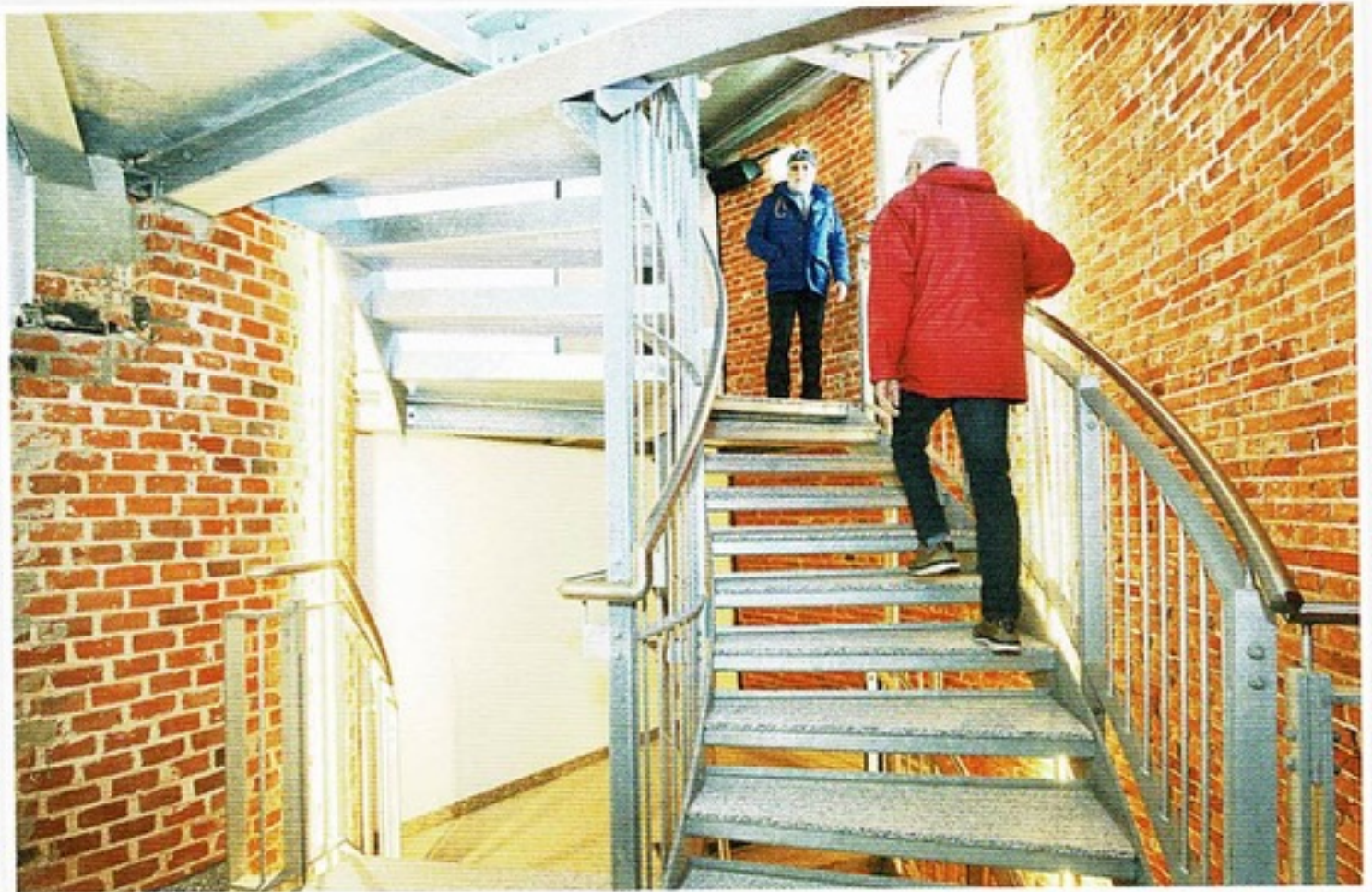
60 Tonnen Stahl wurden vom Erdgeschoss bis zur Laterne verbaut.
